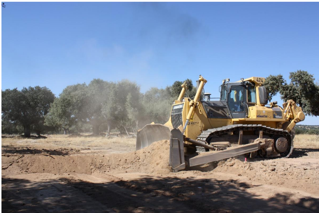
Die Bagger leisten notwendige Vorarbeiten.
